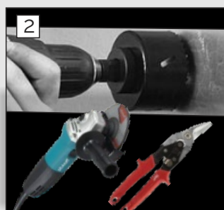
2. Wykonaj otwór dowolnym narzędziem
