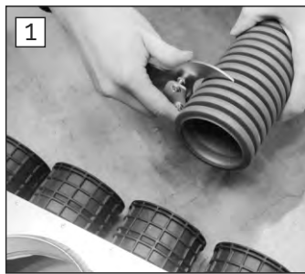
1. Dotnij rurę naszym nożem (gwarantuje to szczelne połączenie)
