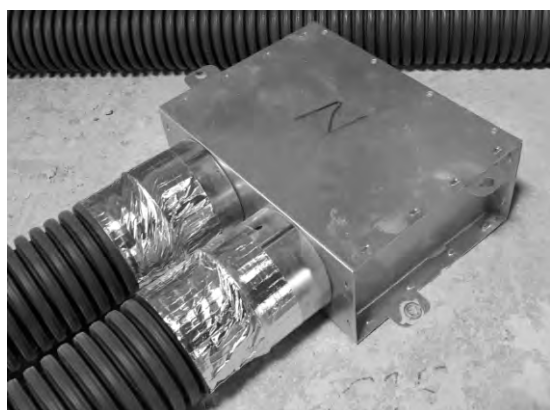
Montaż na stropie
